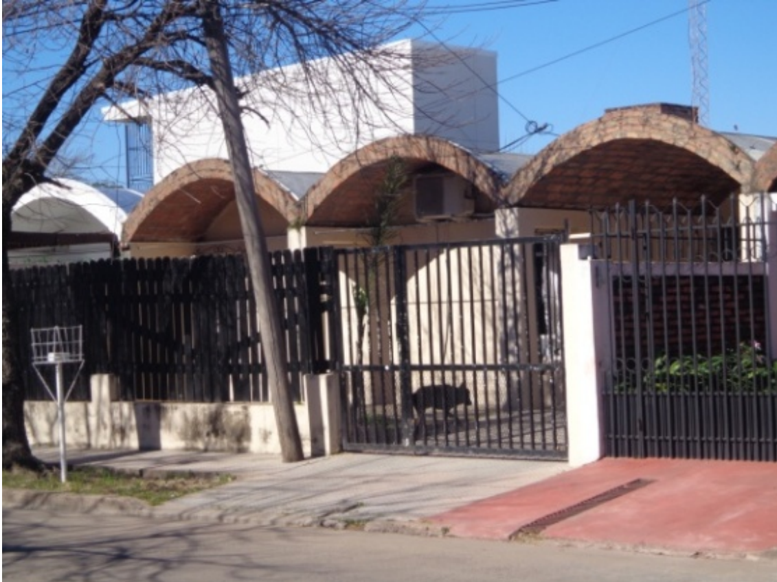
Fig. 3. Vivienda del barrio con el lenguaje original en la fachada, caracterizado por la utilización de cubierta de bóveda de ladrillo
