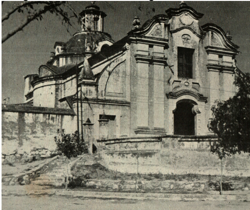
Fotografía 1: Fachada exterior Iglesia de Alta Gracia
