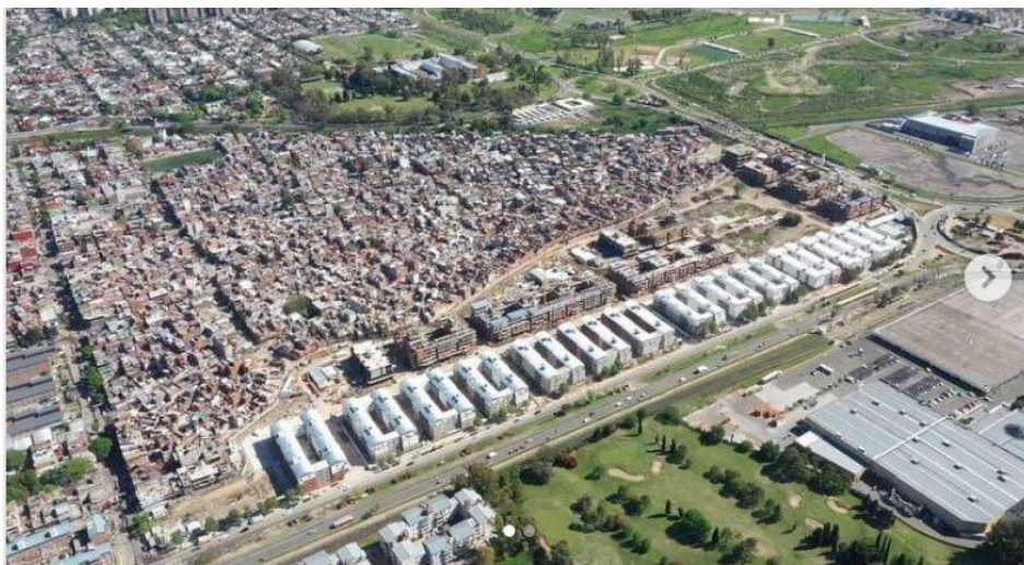
Figura 2: Imagen aérea de la Reurbanización de la villa 20 - diciembre 2018.
