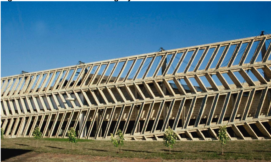
Figura 4: Edificio Unilever Paraguay.
