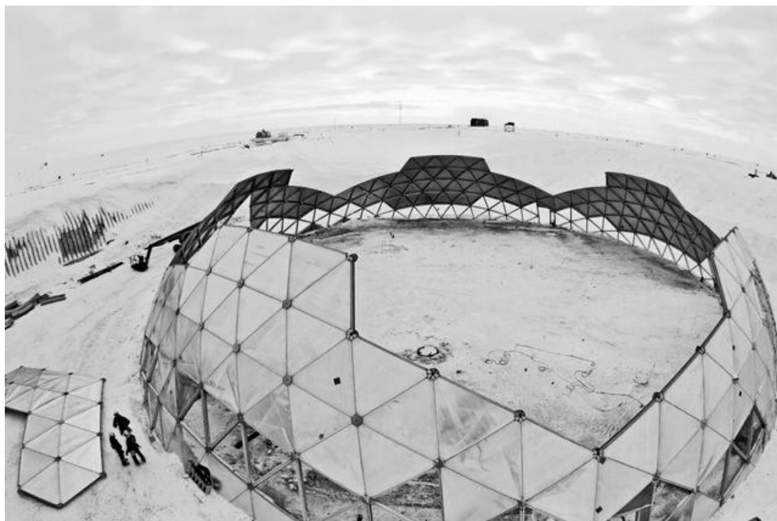
Figura 3: Desmantelamiento del Domo en la base científica norteamericana Amundsen-Scott ubicada en el Polo Sur - (7 Enero 2010)
