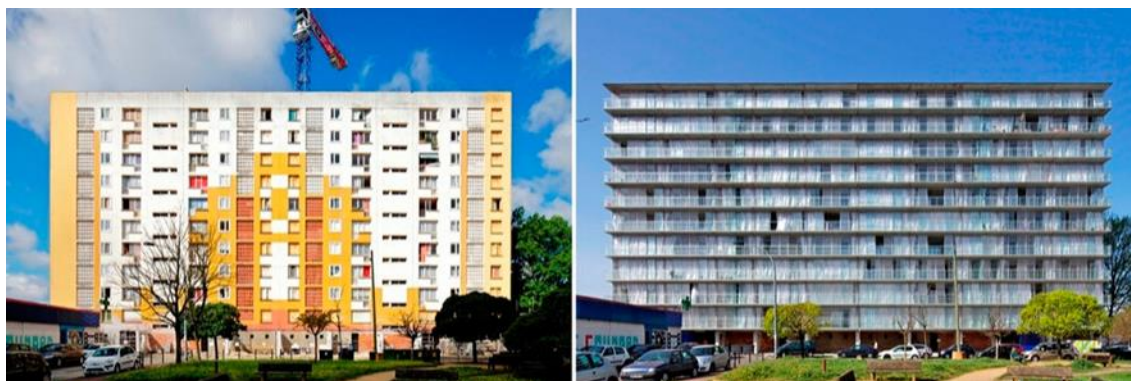
Figura 2: Antes de la intervención, y después...
