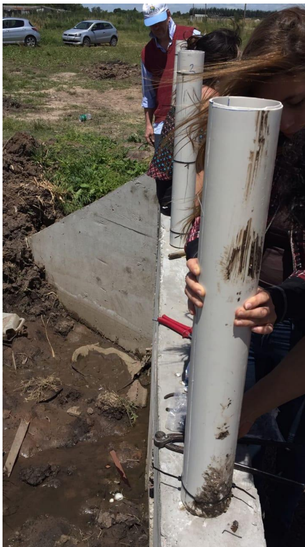
Figura 1 / 2 – Ejecutando parantes de H° en territorio / Armando el stand para el ENAC, previo proyecto del conjunto del taller
