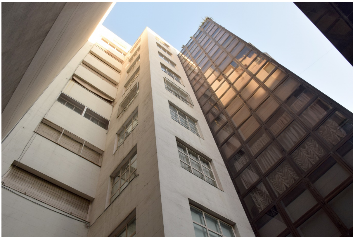
Figura 5: Fachada de Ugarteche 3143.
