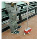
5- Piso: Relevamiento geométrico: medición de planitud con ecímetro
