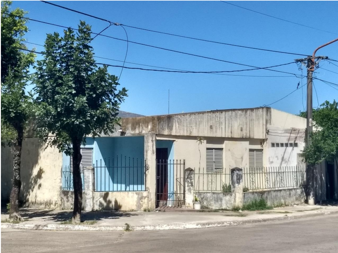
Fig 4. Sector de viviendas individuales.
