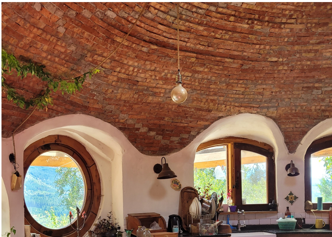
Figura 5. Estructura abovedada de ladrillo en el techo de la vivienda “Susurros del Viento”
