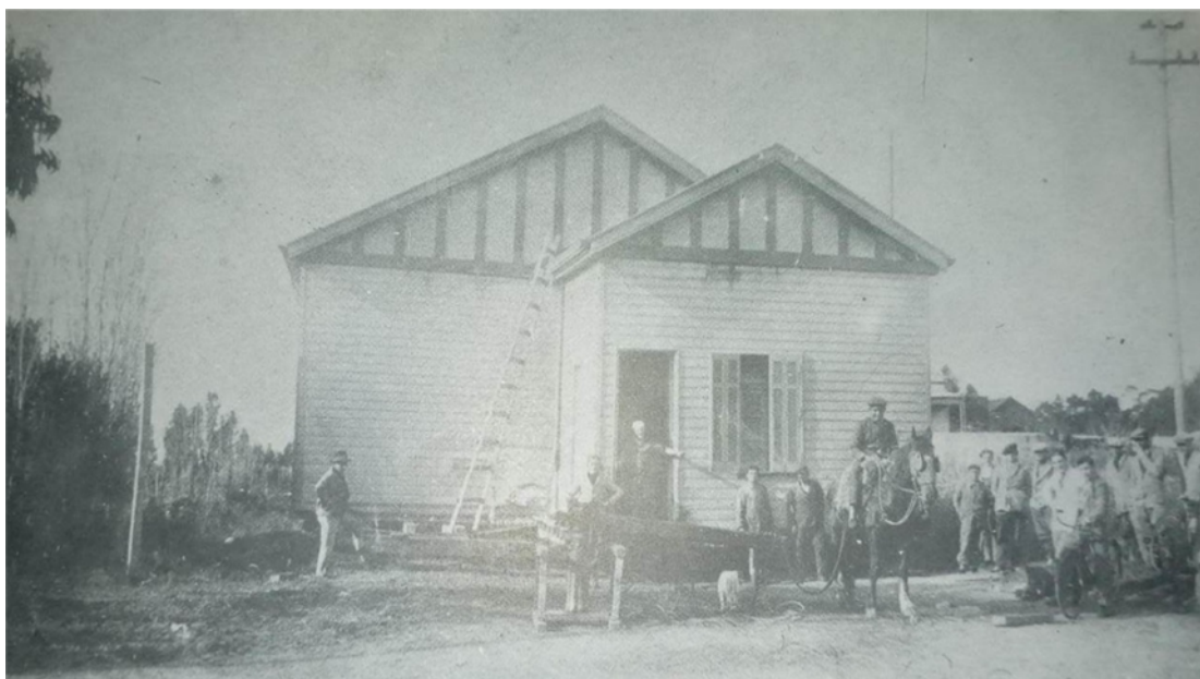
Figura 1: Mudanza de casilla de madera con técnica naval, malacate accionado con caballo
