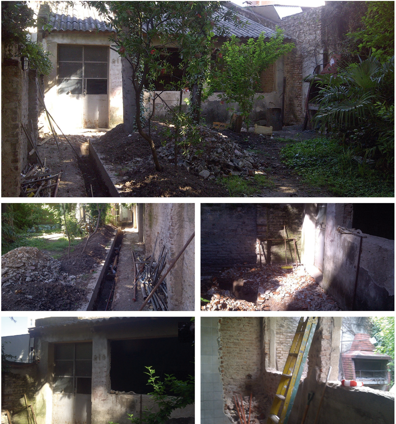
Figura 3: Demolición parcial en fachada original y relleno con escombros obtenidos. (Fotos propias de los autores)
