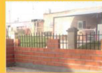
Muro construido para amurar rejas antiguas
