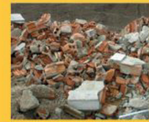
Escombro reutilizado en contrapiso
