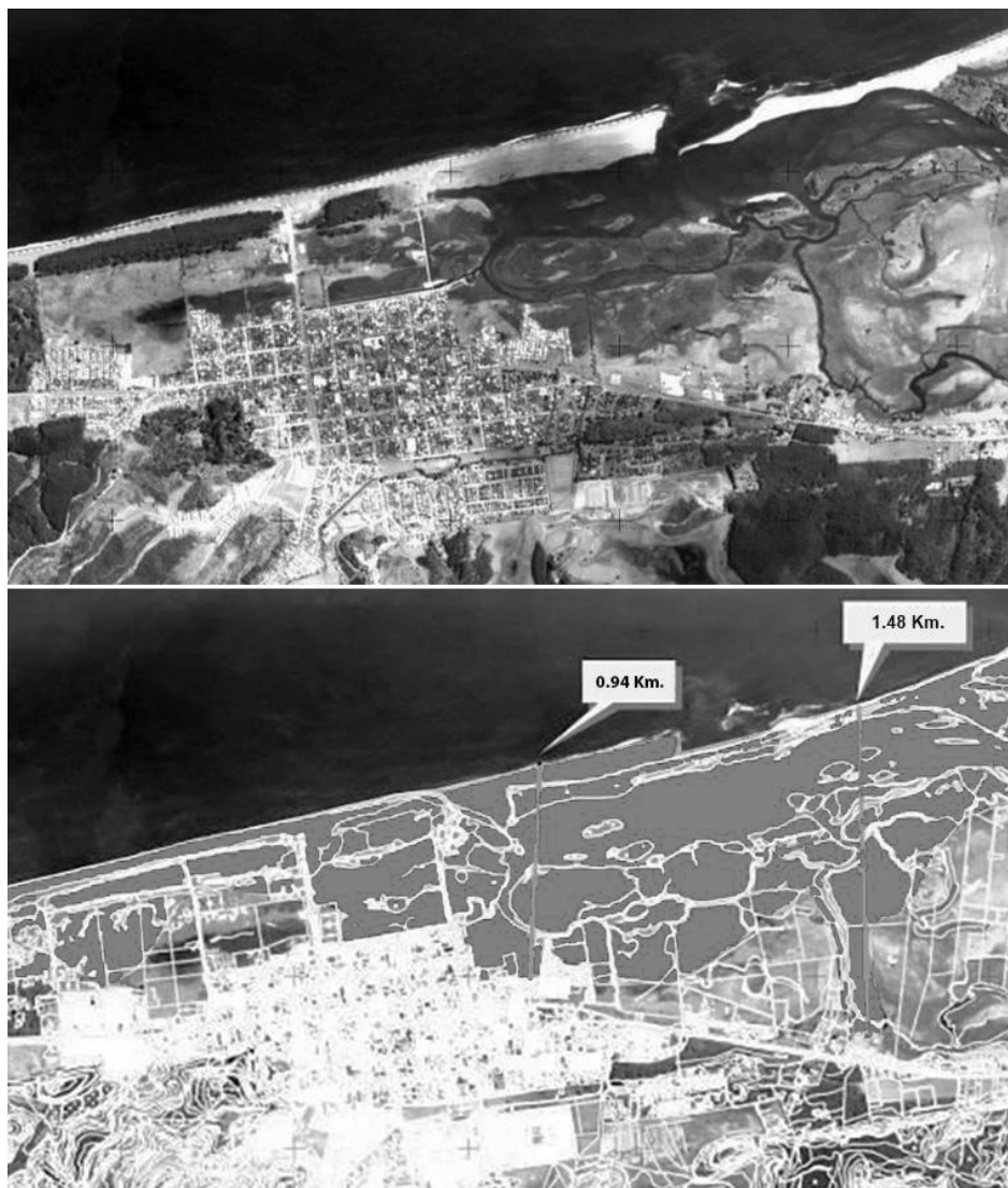
Figura 5: Arriba: imagen satelital de la localidad de Arauco, región del Biobío, Chile. Abajo: plano con área de inundación del tsunami de febrero 2010. Se observa el rol de los humedales costeros y el cordón dunario paralelo a la costa como infraestructura de amortiguación de los efectos de inundación por tsunami, que resguarda la zona urbana. Fuente: Elaboración propia en base a Belmonte et al. (2011).
