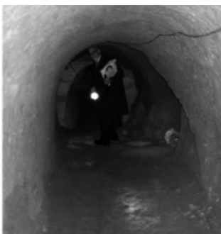
Figura 2: Greslebin y Ayerza en túnel Manzana de las Luces ca. 1918. Fuente: Mayochi, E. M; Poitevin, N. E. y Gazzaneo, J. O. 1997:18.
