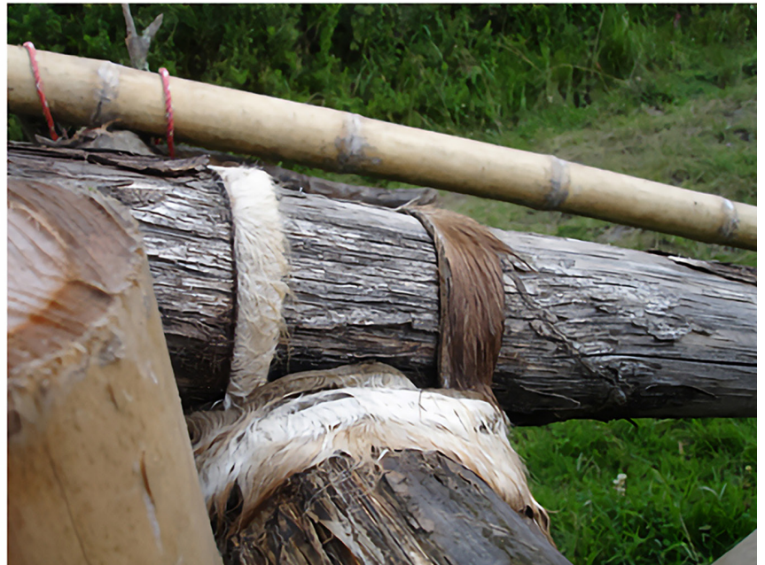
Figura 1 Colección de resoluciones constructivas para encuentro entre caños o palos. Arriba: accesorios metálicos. Abajo: ataduras con cuero animal. Fuente: gentileza de Al Borde.
