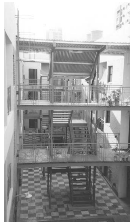
Figura 4 Operatoria Renovación de conventillos (Programa La Boca), Palos 460, 31 viviendas, obra licitada en 1997, finalizada en abril de 2000. Fotografía: archivo PMH-FADU-UBA.
