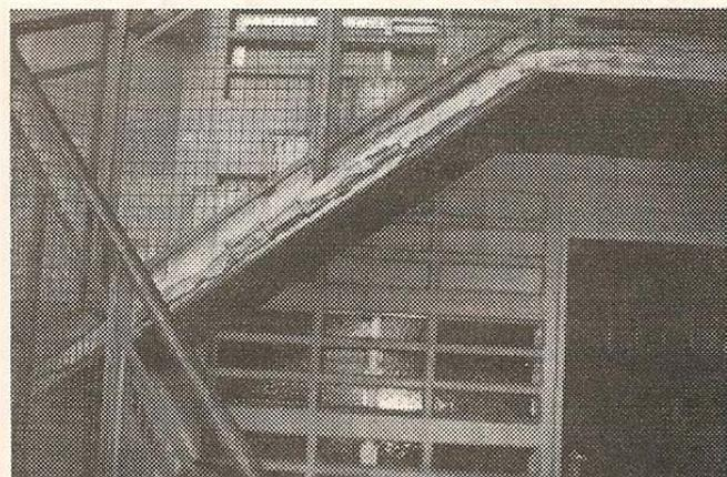
Figura 1: 1a) Infiltración de agua por juntas, debida al descascaramiento de vértices y aristas de paneles premoldeados de hormigón. 1b) Riesgo estructural en medios de salida, debido a armaduras expuestas en tramos de escaleras premoldeadas de hormigón.
