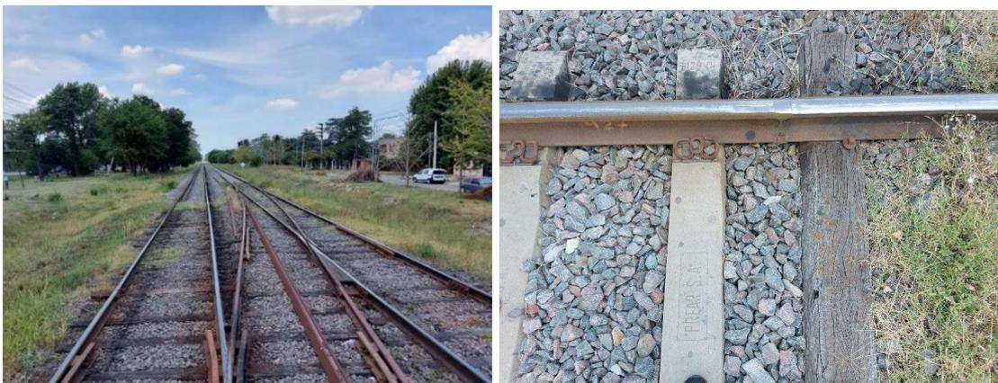
**Figura 4. Renovación de vía discontinua** Fuente: fotografías propias. Aquí se decidió mantener el cambio de vía y solo contratar la renovación del balasto junto a una enrielladura simple. El reemplazo del cambio nunca se produjo. Conviven durmientes y fijaciones nuevas con las viejas, que imponen reducciones de velocidad. Ejemplo próximo a una estación en la que no puede justificarse razonablemente la expectativa de rotación de las formaciones.
